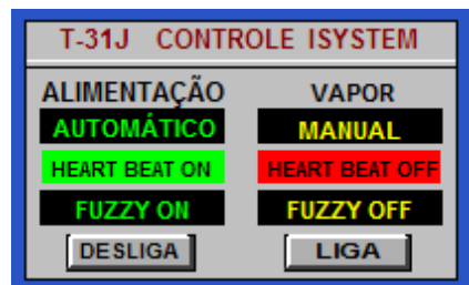
Figura 5. Aviso de falha de comunicação na tela de operação de uma das torres.
