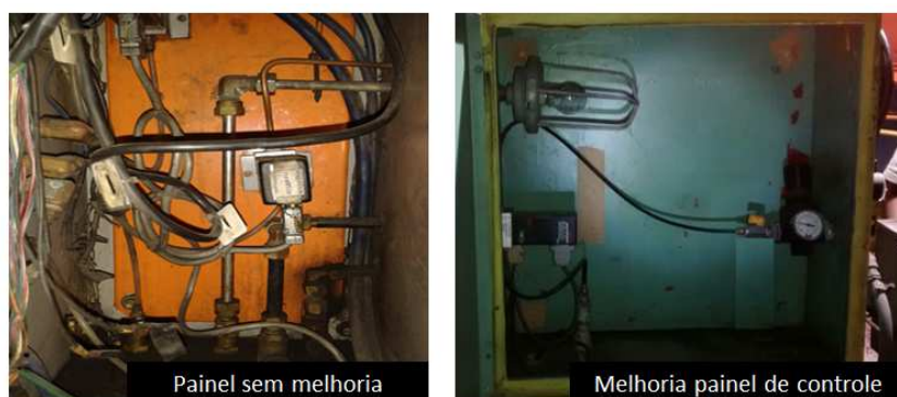
Figura 8 – Painel de controle argônio antes e depois da intervenção.
