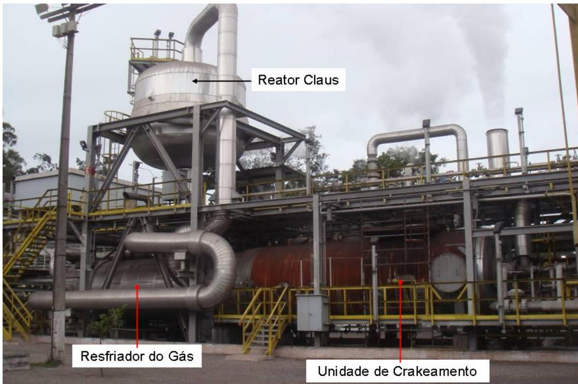
**Figura 4.** Vista geral da Planta de Dessulfuração de Vapores Amoniacais.
