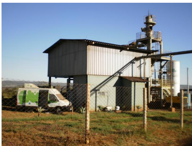
Figura 3. Planta piloto de combustão na VMN Niquelândia junto ao veículo de monitoramento on-line de emissões do IPT.
