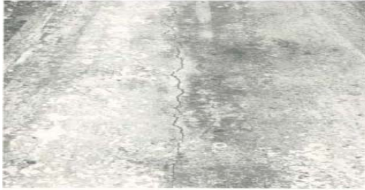
Figura 2. Trinca Longitudinal no centro da face de uma placa de lingotamento contínuo. (2)
