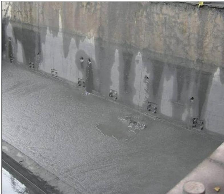
**Figura 1.** Pó sobrenadante no poço de decantação.
