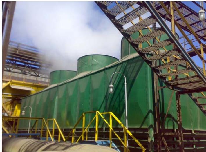
**Figura 14.** Vista da lateral das células 1, 2 e 3 reformadas.
