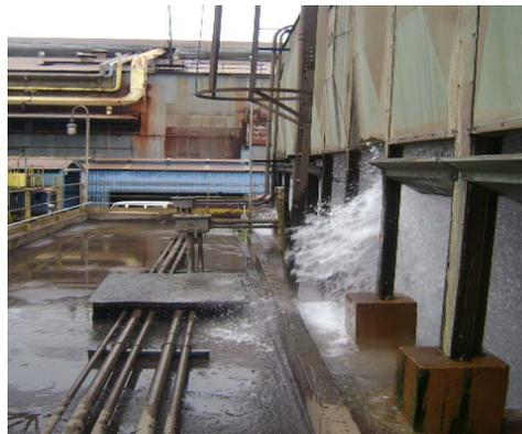
Figura 4. Perda de água para a área externa da torre.
