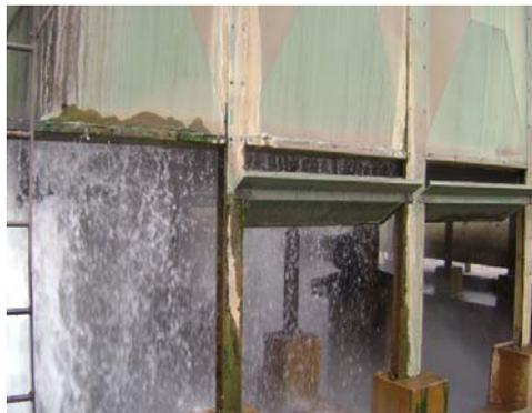
**Figura 7.** Detalhe da célula sem venezianas e da estrutura da torre.
