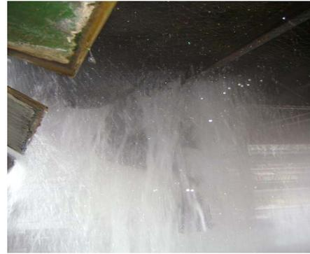
**Figuras 5.** Distribuição inadequada de água no interior da torre.
