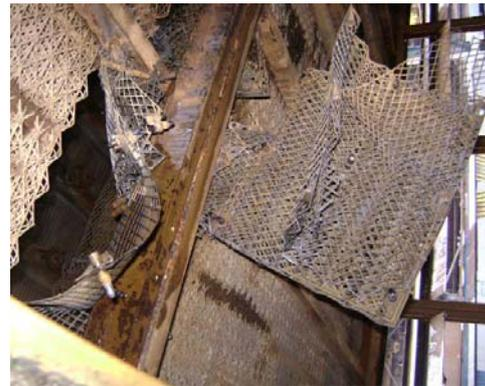
**Figuras 6.** Queda das grades de enchimento no interior da torre.
