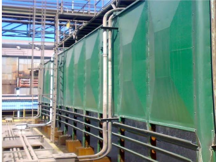
**Figura 13.** Vista da lateral das células com as venezianas instaladas e sem vazamentos externos.
