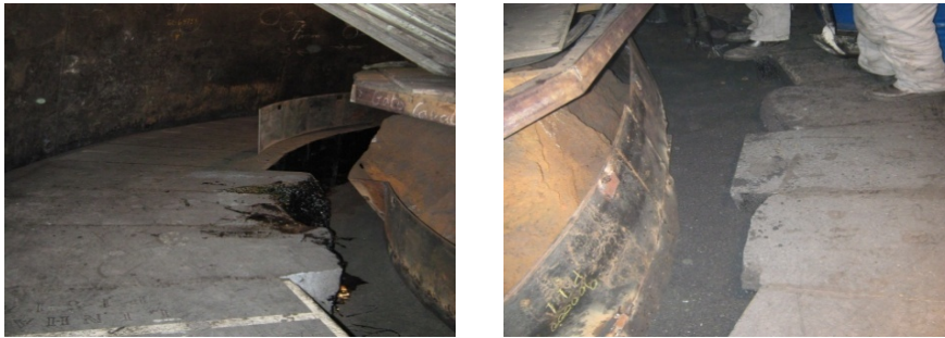
Figura 17. Introdução da massa entre o bloco de carbono e a salamandra.
