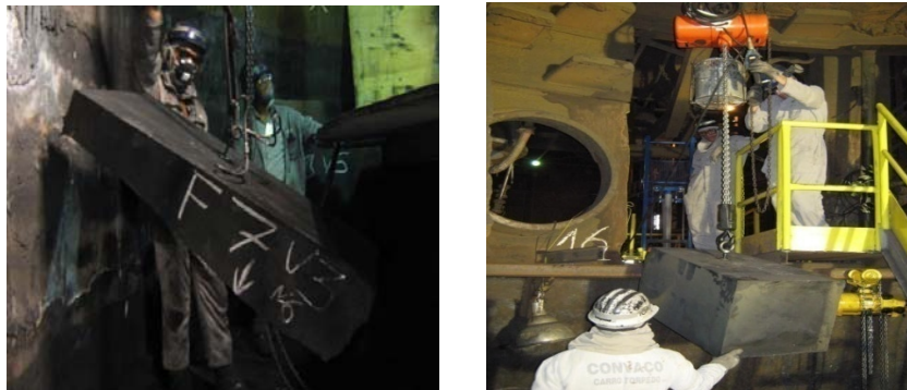
Figura 11. Desmontagem e retirada dos blocos de carbono.
