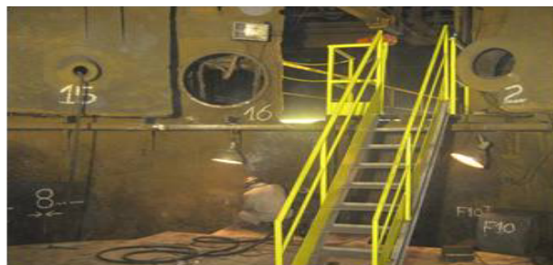
Figura 10. Plataforma e escada de acesso ao interior do cadinho.
