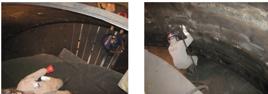
Figura 16. Montagem dos blocos de carbono.
