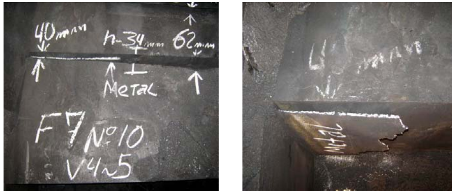
Figura 13. Penetração de gusa entre os blocos de carbono.
