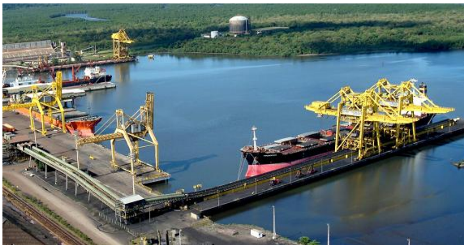
Figura 1: Vista aérea do porto da COSIPA - TMPC
