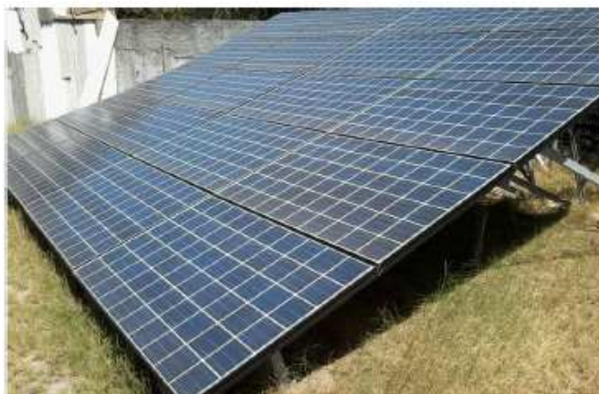
Figura 2. Instalação do Sistema Fotovoltaico Policristalino na APAE-Búzios.
