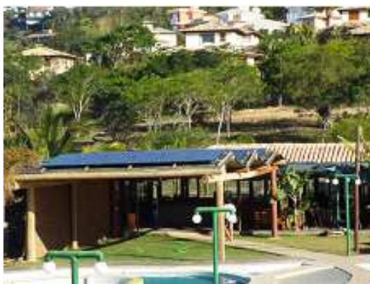
Figura 4. Instalação do Sistema Fotovoltaico no Clube de Tênis [9].
