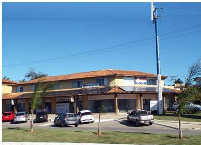
Figura 1. Instalação do Sistema Fotovoltaico e Eólico [9].
