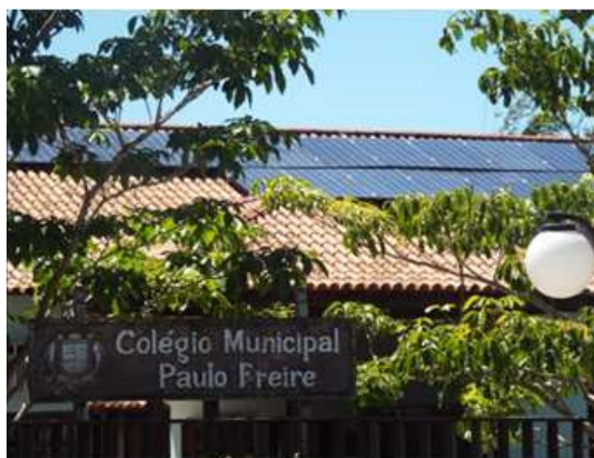
Figura 3. Instalação do Sistema Fotovoltaico no Colégio Municipal Paulo Freire [9].
