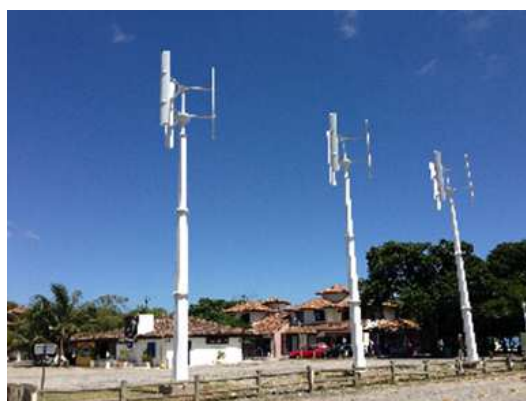
Figura 5. Instalação dos Aerogeradores de Eixo Vertical no Porto da Barra [9].
