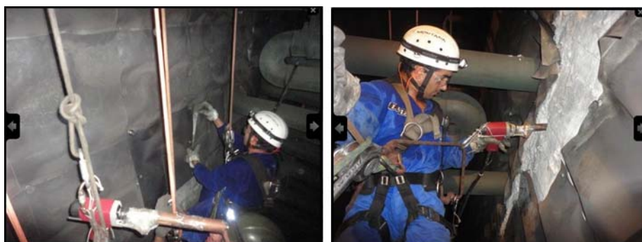
Figura 22- Alpinistas na substituição das chapas
