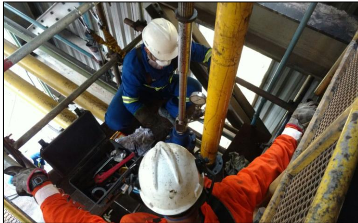
Figura 11: Execução da atividade de Trepanação – Furo em carga.
