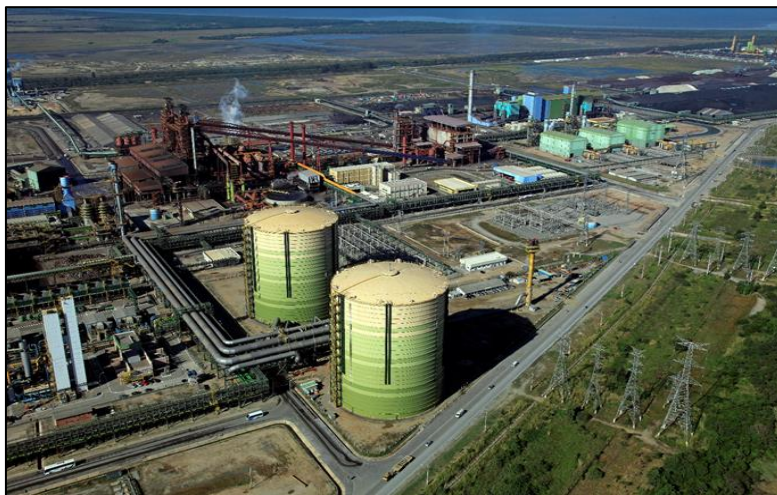
Figura 1. Visão aérea dos gasômetros de BFG e BOFG
