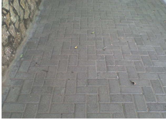
Figura 4 – Blocos de concreto natural aplicados em pavimentos leve.
