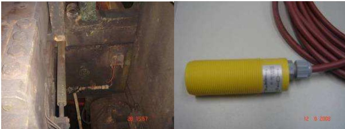
**Figura 3.** Localização do sensor indutivo da guia de entrada e Sensor indutivo utilizado no local.
