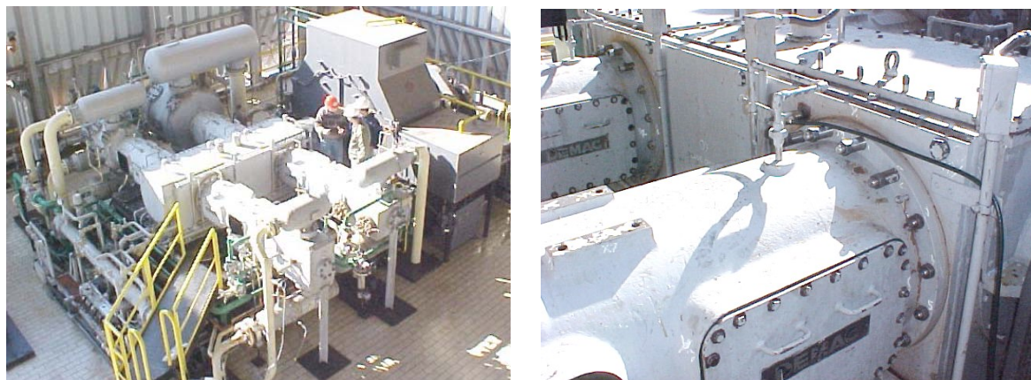
Figura 1.1 - Pré-compressor de quatro estágios identificando o modo de fixação do flange à carcaça através de parafusos prisioneiros.
