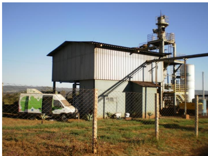
Figura 2. Planta piloto de combustão na VMN Niquelândia junto ao veículo de monitoramento on-line de emissões do IPT
