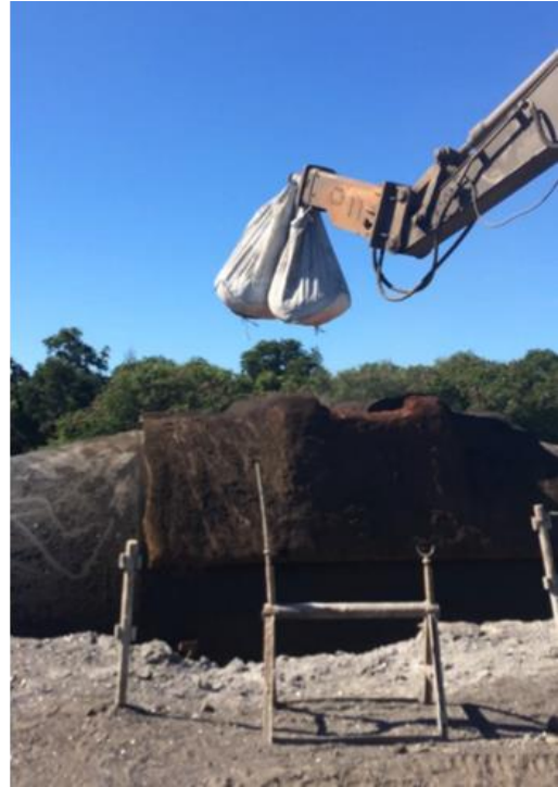
Figura 5. Adição de SGD em CT via bag
