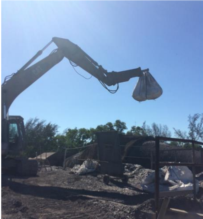
Figura 5. Adição de SGD em CT via bag
