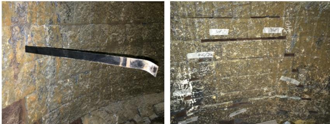
Figura 7 – Medição das espessuras dentro do vaso RH
