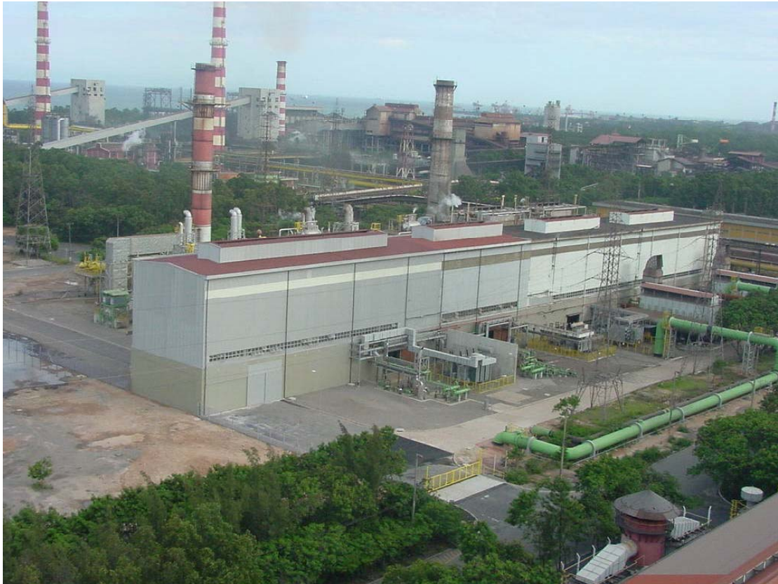
Figura 1. Foto da Central Termelétrica.
