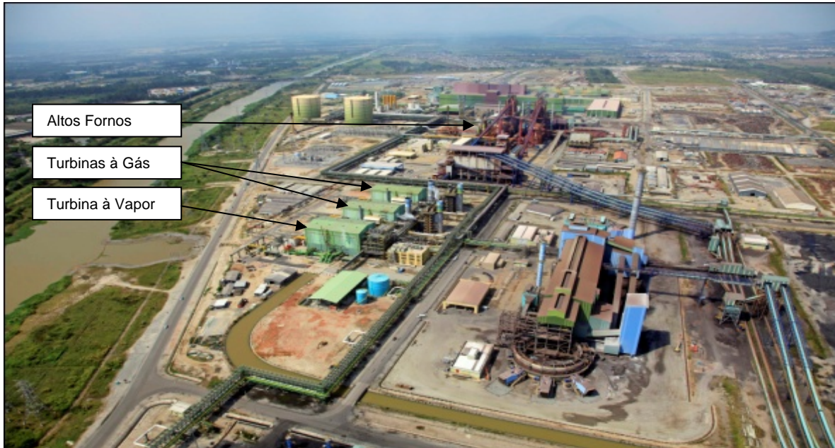
Figura 1. Visão panorâmica do complexo siderúrgico da TKCSA. Destaque para as plantas dos Altos Fornos e para a Termelétrica.
