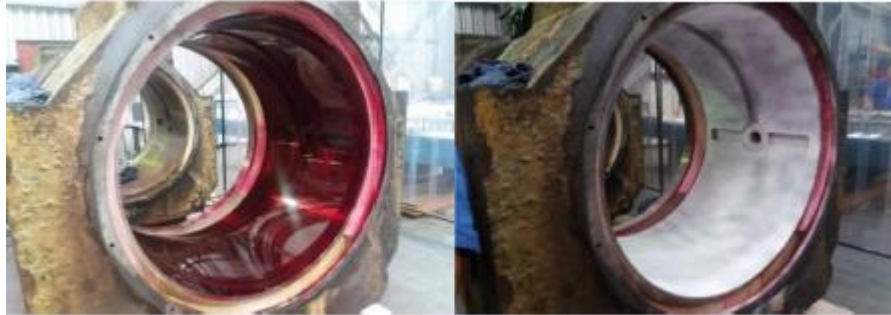
Figura 11. Inspeção por Líquido Penetrante no diâmetro interno de um mancal do Backup Roll
