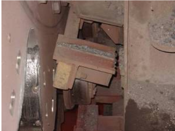
Fonte: ArcelorMittal Tubarão. Figura 12. Quebra suporte trilhos curvos.
