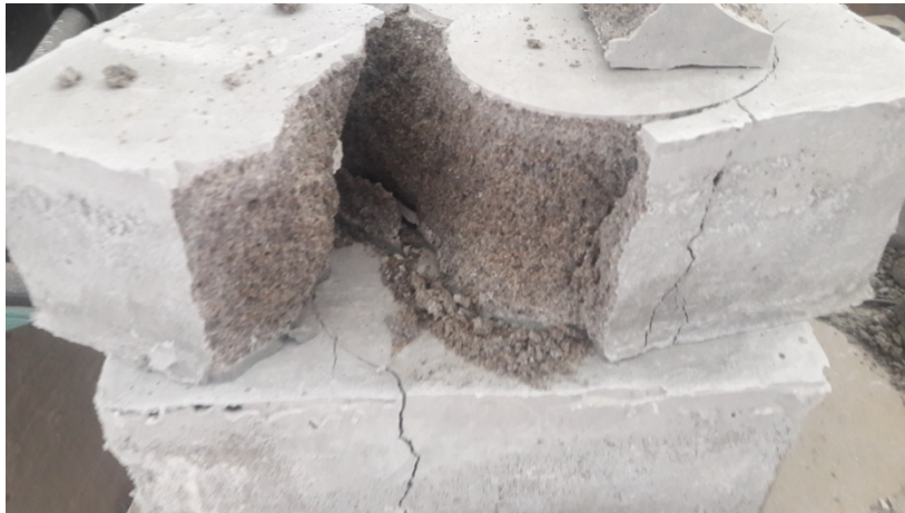
Figura 3 – Bloco A após ruptura.
