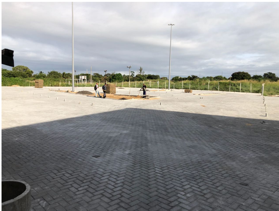
Figura 1 – Local de colocação dos blocos de concreto.
