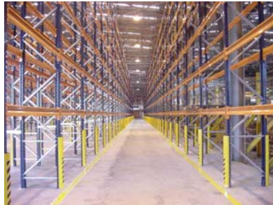
Figura 13. Montagem do sistema porta-pallet.
