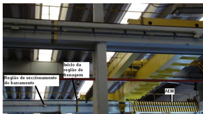
Figura 6 – Área Exclusiva para Manutenção – AEM.
