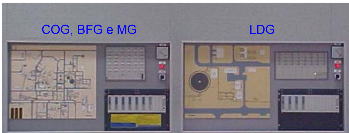
Figura 5. Painéis sinópticos do sistema de detecção de CO
