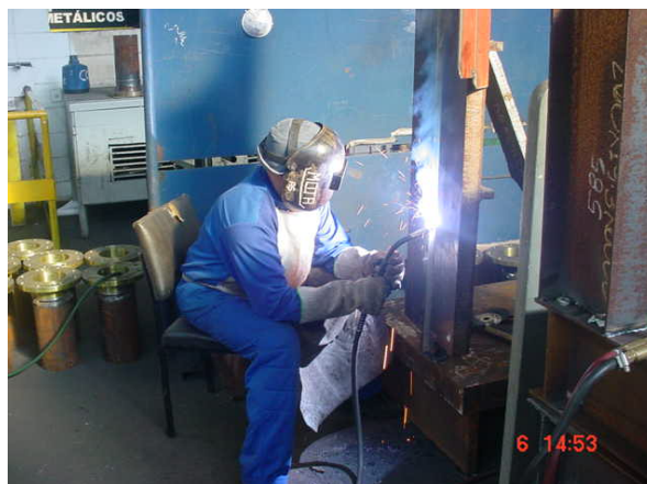
Figura 2 – Soldagem da junta de teste
