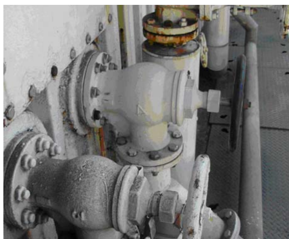
Figura 7. Válvula de dreno do Adsorvedor
