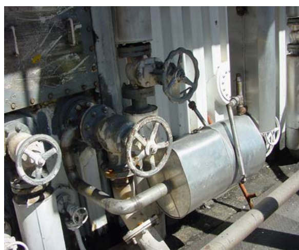
Figura 6. Carretel do Adsorvedor de LOX.
