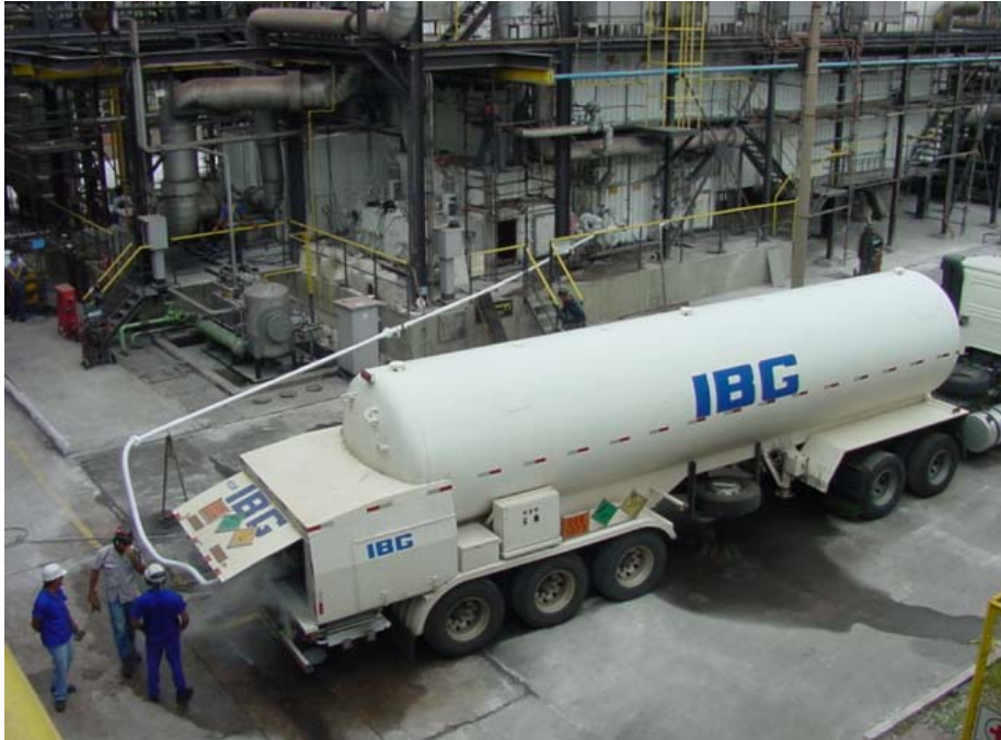
Figura 2. Foto aérea do processo de injeção via carreta.
