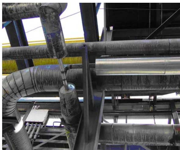
Figura 8. Interligação com o coletor
