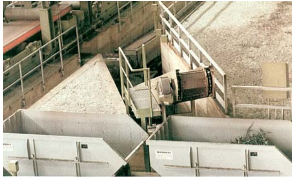
Figura 7. Vista de um sistema de remoção de rebarbas.
