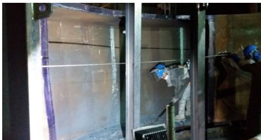
Figure 6 – Abertura na carcaça e anel do conversor.
