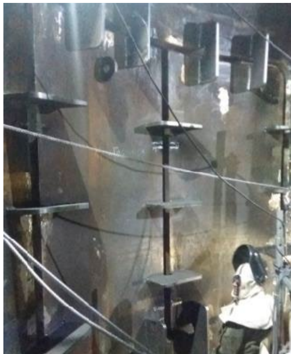
Figure 8 – Chapas novas posicionadas no vaso.
