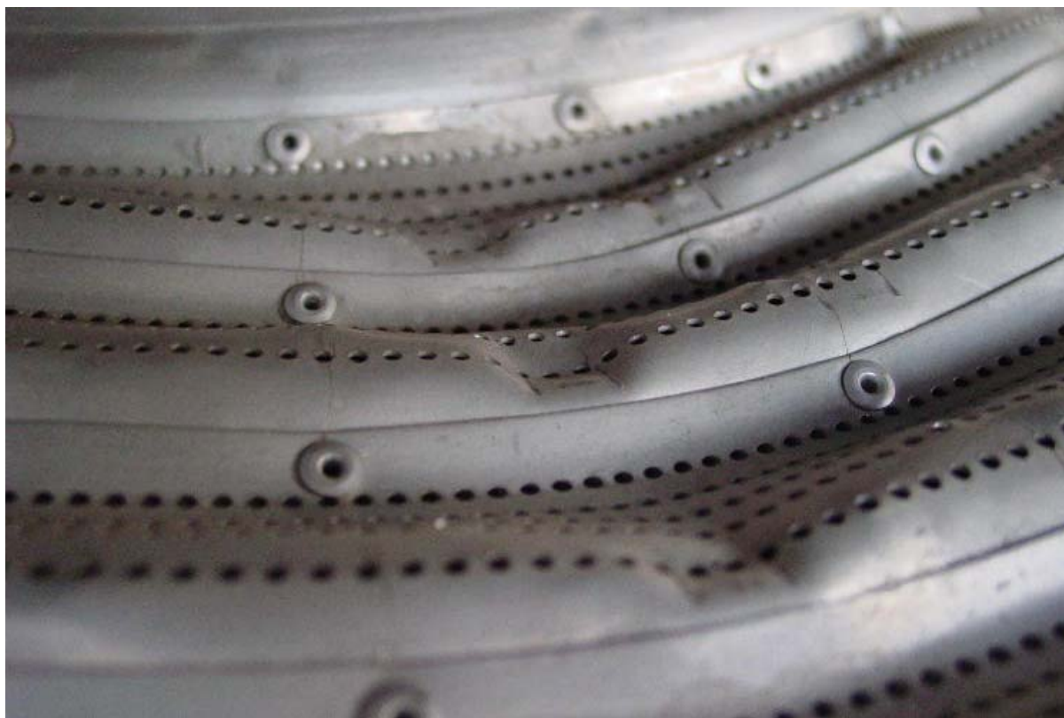
Figura 1 - Aspecto Detalhado do Prato 17 da Coluna, com Sinais Evidentes de Amassamento.
