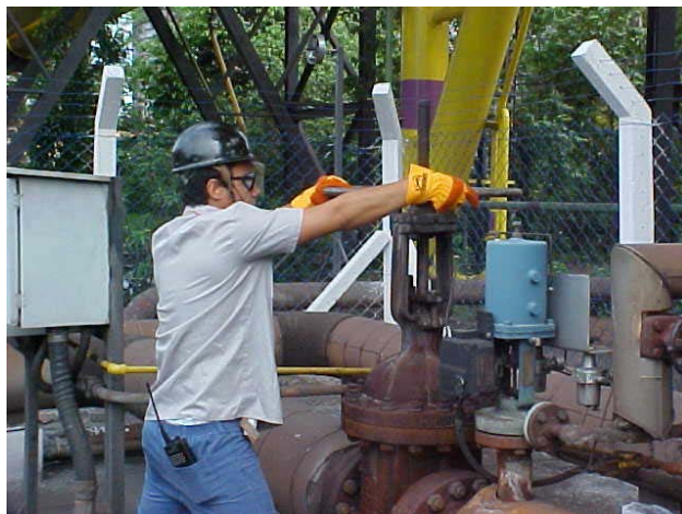
Figura 6. Manobras na rede de vapor.
