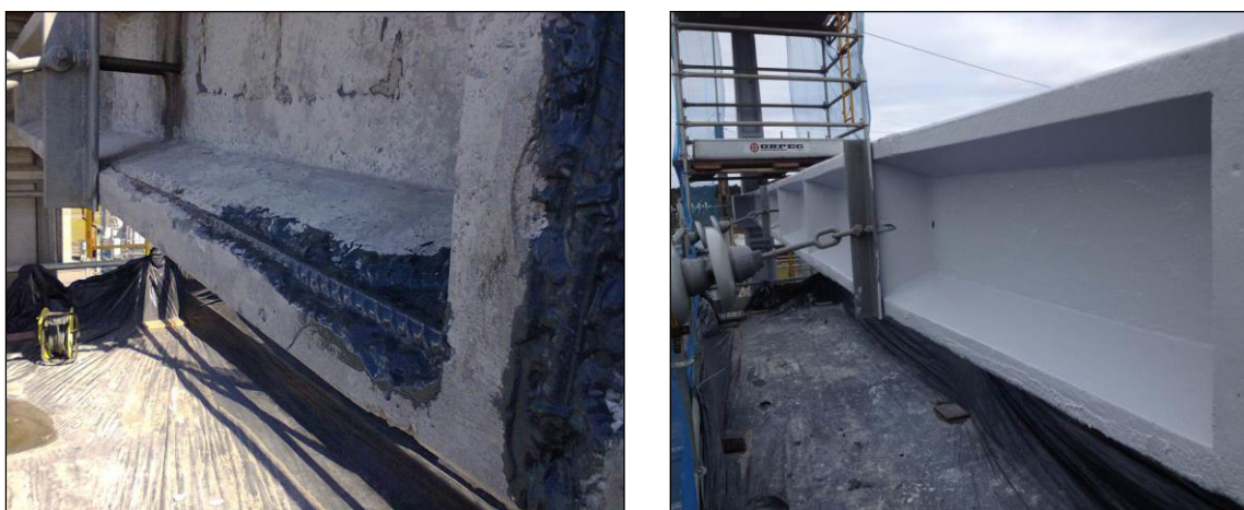
Figura 6: Pórtico de Entrada da Linha 01 sendo reparado
