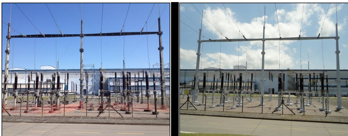
Figura 8: Antes e depois da Recuperação das Estruturas
