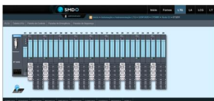
Figura 8 – SMDO – Sistema de Automação: CLP
