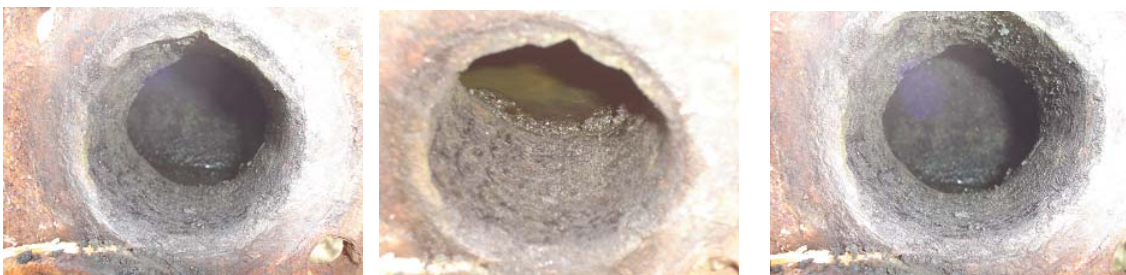
Figura 8 Inspeção realizada após término do teste. Janela de visita aberta na tubulação para inspeção do antes e depois do teste.
