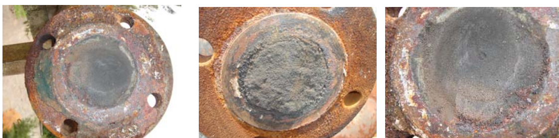
Figura 3. Inspeção realizada antes do início do teste. Flange localizado a aproximadamente 200m do aquecimento dos carros torpedo.
