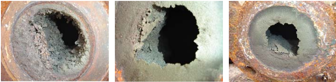
Figura 5 Inspeção realizada antes do início do teste. Flange localizado a aproximadamente 50m do aquecimento dos carros torpedo.
