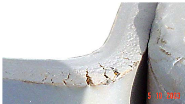
Figura 2 – Trincas oriundas do processo de conformação (dobramento) de um aço com alta resistência mecânica.
