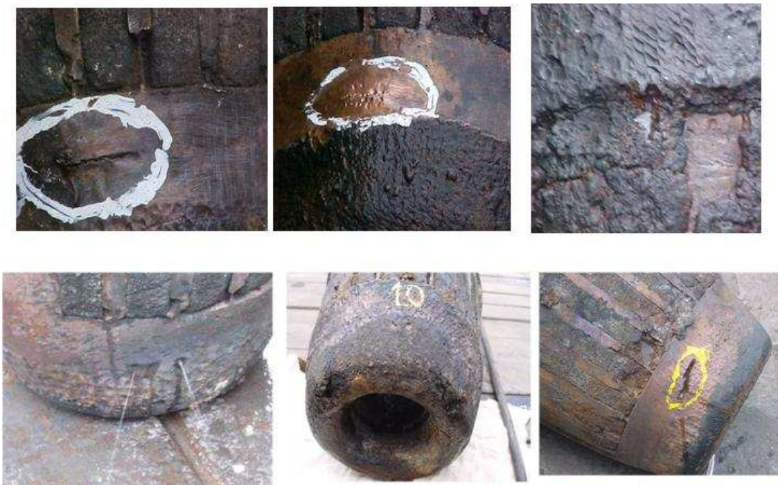
Figura 3 - Ocorrência de trincas e desgaste no revestimento das ventaneiras.
