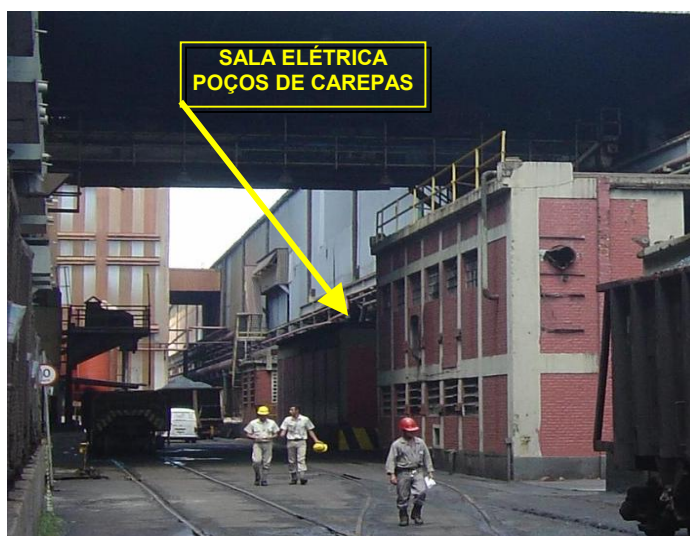
Figura 9. Área externa dos Poços de Carepas das Laminações
