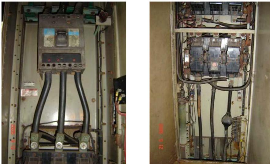
Figura 6. Painel antigo da GE vista do Disjuntor e do Contatores
