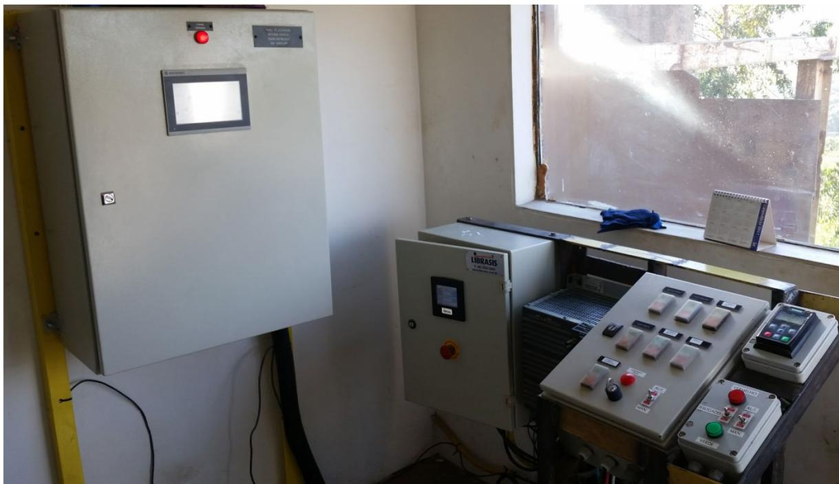
Figura 2 – Sala de operação da britagem primária. O painel de automação está localizado no lado esquerdo e a mesa de comando está localizada no lado direito.
