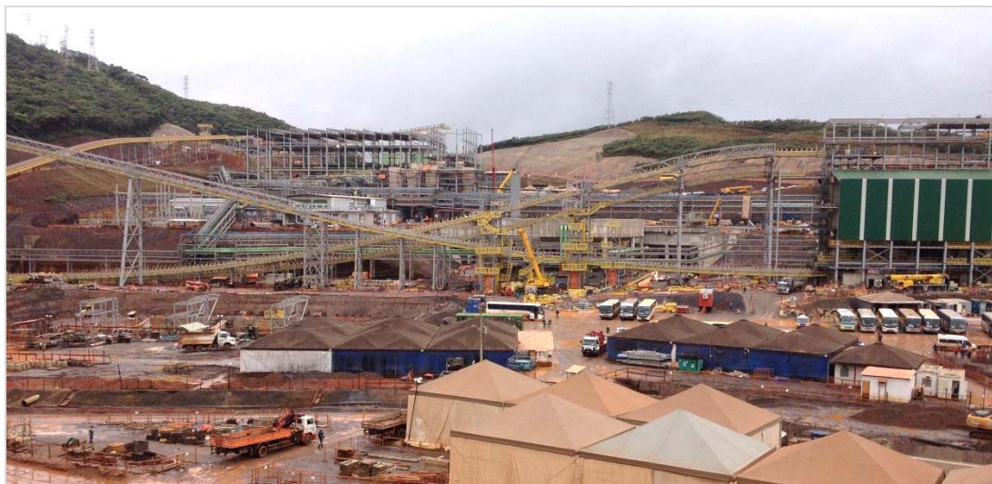
Figura 2. Foto da construção do 3º Concentrador de Minério de Ferro.
