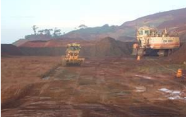
Figura 3 – Acerto da praça de carregamento por motoniveladora. (Pesquisa Direta, 2017)
