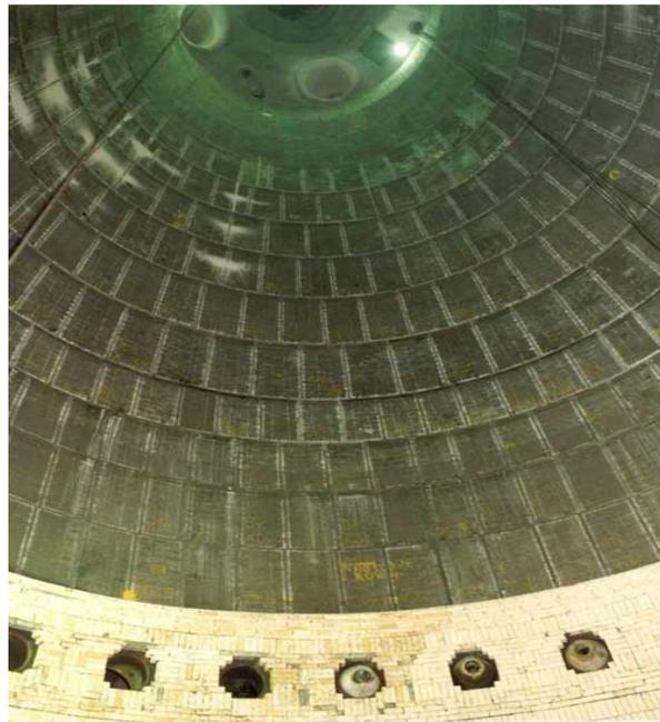
**Figura 2.** Montagem de um alto forno com stave cooler para proteção da carcaça.
