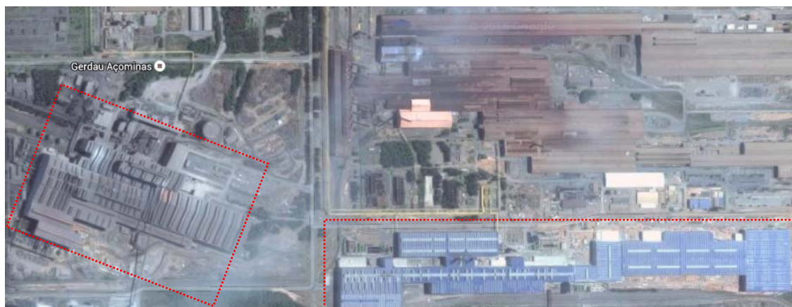
Figura 10 – Aciaria e Laminação de Chapas Grossas da Usina de Ouro Branco
