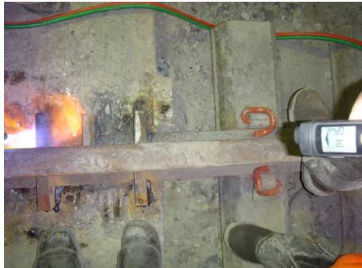
Figura 7. Procedimento de controle de temperatura durante solda dos elementos de fixação.
