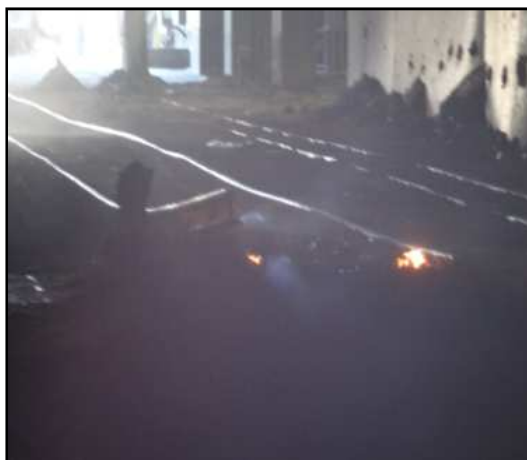
Figura 4. Via férrea danificada durante operação – Convertedor 1 – Junho/14.
