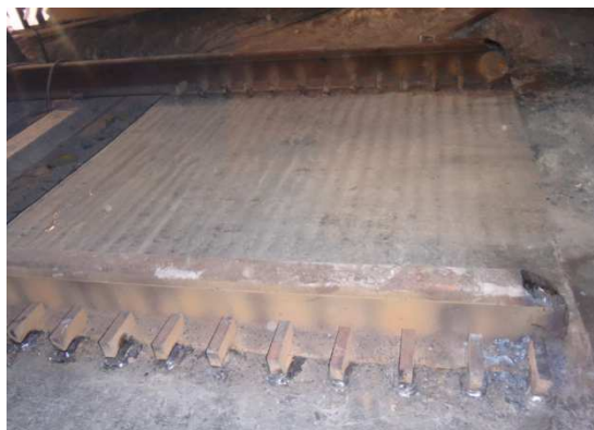
Figura 8. Fixação dos trilhos sobre os placões.
