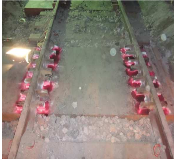
Figura 10. Ensaio de líquido penetrante nas soldas dos elementos de fixação.
