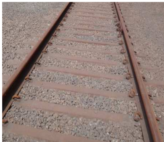
Figura 3. Fixação tradicional utilizada na ArcelorMittal Tubarão.
