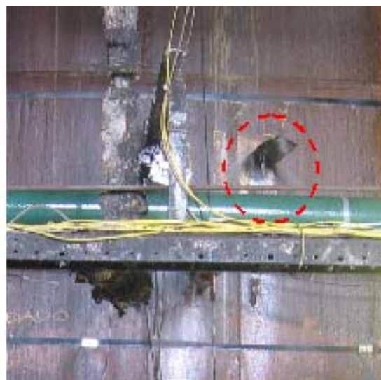
Figura 5 – Detalhamento da instalação dos extensômetros (Strain Gauges)
