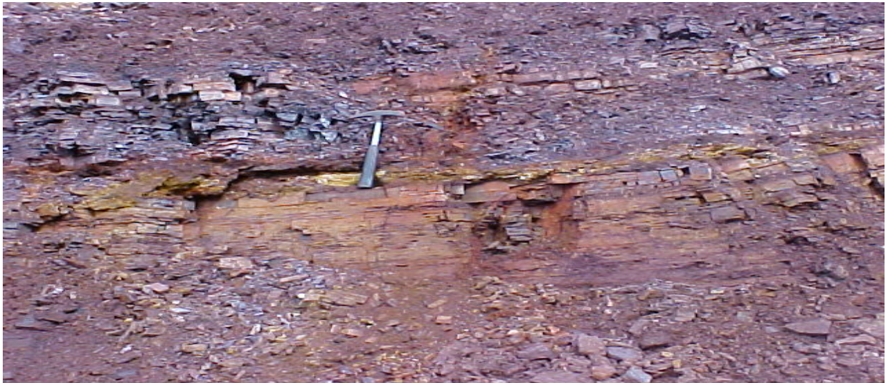
Figura 5 – Vista do Minério na Frente de Lavra
