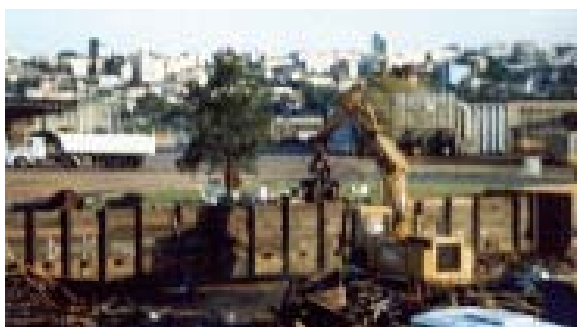
Figura 2. Carregamento de metálicos em vagão-plataforma adaptado
