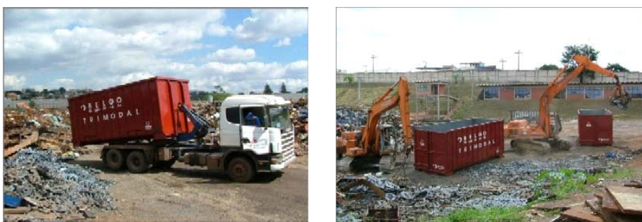
Figura 8. Posicionamento e carregamento das caçambas com sucata
