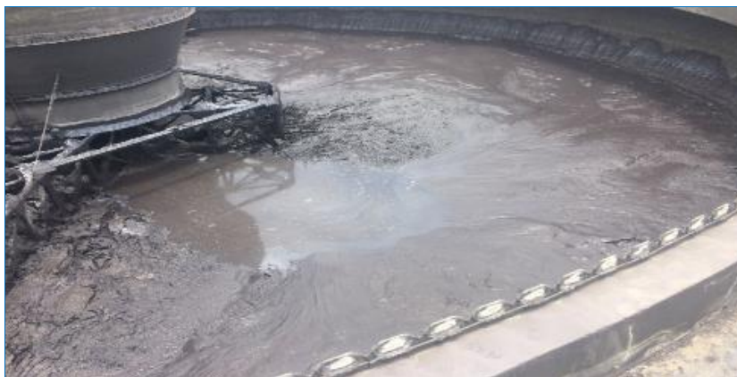
Figura 02 : Vista do espessador sem água, durante a parada para 1ª lavagem em agosto/2016.
